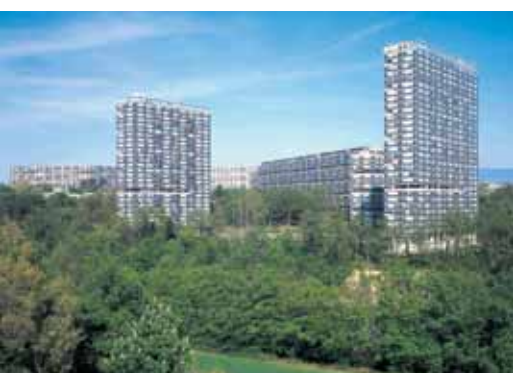
Le Lignon, construit par les architectes Georges Ador, Jacques Bolliger, Dominique Julliard, Louis Payot.
